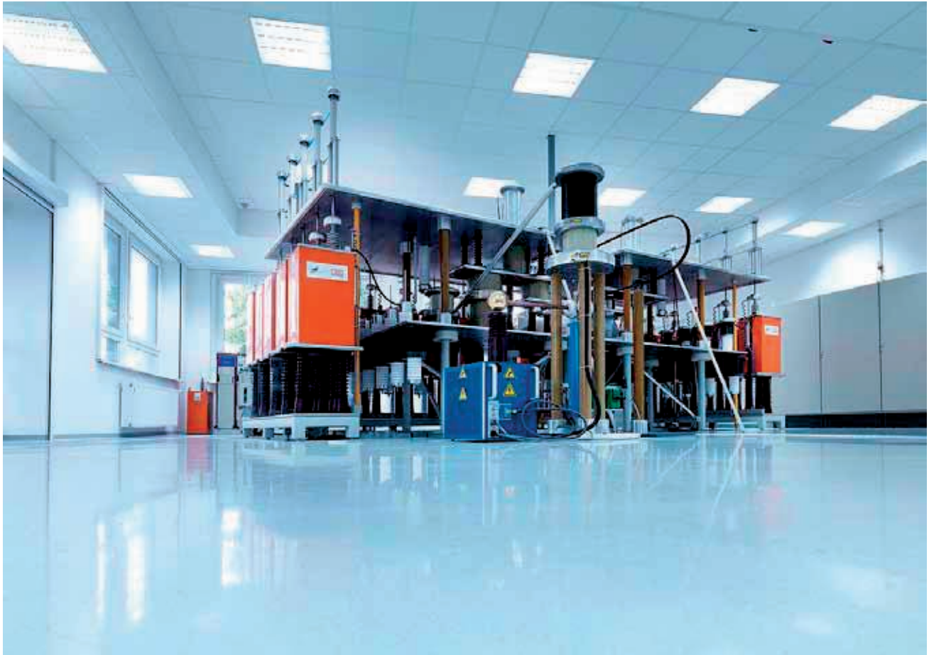
Generator struje munje
