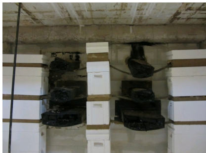
Slika 9: Ulaz instalacije u prostor za spaljivanje
