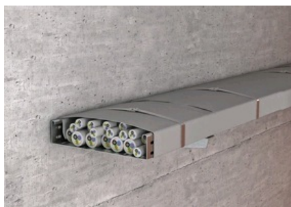
Slika 18. Bandažirana kableska trasa pričvršćena na zid
