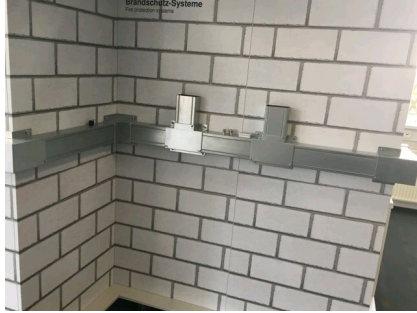
Slika 3: Montaža direktno na zid
