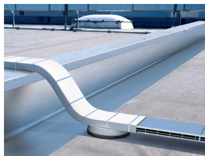
Slika 28: Prijelaz instalacije preko požarnog zida
