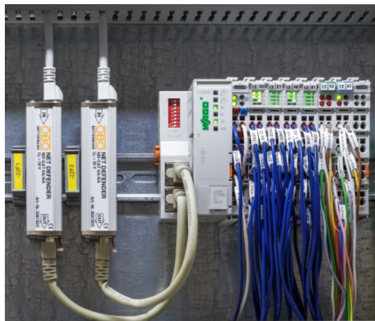
Slika 2. Ugrađena zaštita OBO Net-Defender
