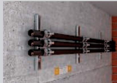
Prostorno štedljiva instalacija više cijevi s BBS obujmicama.
