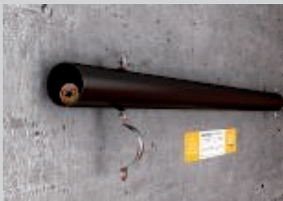
Montaža cijevi na odstoynu obujmicu zatvaranjem gornjeg dijela obujmice.
