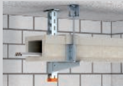
Montaža kao E-kanal s navojnom šipkom za dodatno osiguranje.
