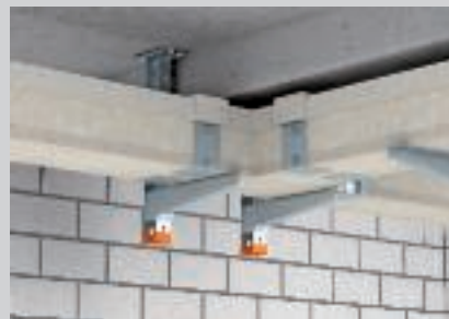
Unaprijed izrađeni elementi za standardnu promjenu smjera trase.
