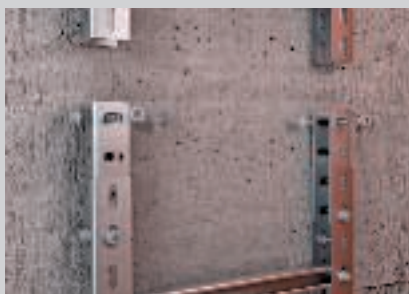
Spajanje ljestvi s pričvršćenom spojnicom.
