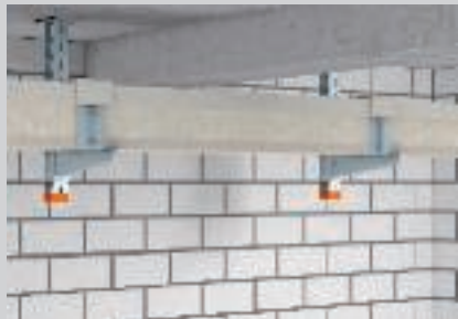
Ovjesna stropna montaža kao I-kanal.
