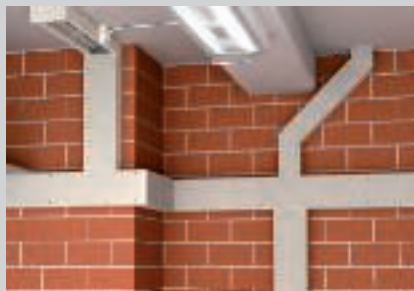
Montirani vatrootporni kanal na zidu i stropu kao I-kanal i E-kanal.
