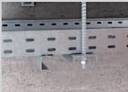
Pričvršćenje okomite navojne šipke na donjoj kabelskoj polici.
