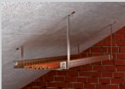
Montaža ispod kosog stropa s individualno prilagođenim ovjesnim elementom.
