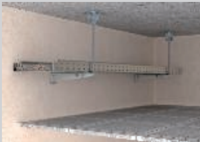
Moguća je i montaža na zid u jednoj ili dvije razine.
