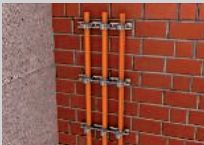
Okomita montaža kabela s BBS obujmicama na zidu.
