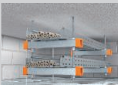
Stropna montaža iznad spušenog protupožarnog stropa u dvije razine.
