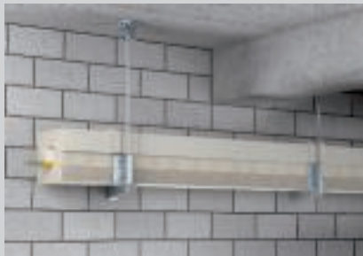
Zidna montaža na konzolama i dodatnoj navojnoj šipki.
