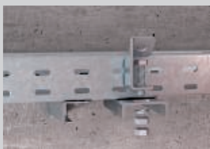
Pričvršćenja kosog priključnog elementa.
