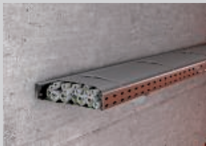
Pričvršćivanje bandaže s metalnim zateznim trakama kod instalacije s montažnim profilima.
