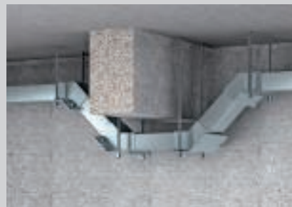
Ovjesna montaža s vertikalnom lučnom spojnicom.
