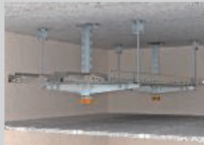
Ovjes sa stropa s obostrano raspoređenim konzolama u jednoj razini.
