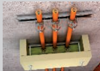
Učinkovita mjera rasterećenja vertikalnog razvoda pomoću seta za vlačno rasterećenje ZSE90.
