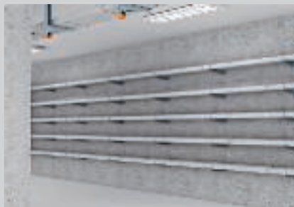
Omotana trasa u tunelu elektrane.
