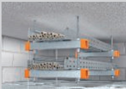
Dvoslojna stropna montaža iznad spušenog protupožarnog stropa.
