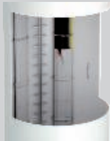
Omotana vertikalna trasa u tornju vjetroelektrane.
