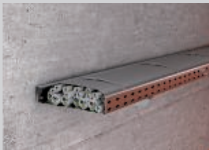
Kompletno omatanje kabelaške trase kod zidne montaže.
