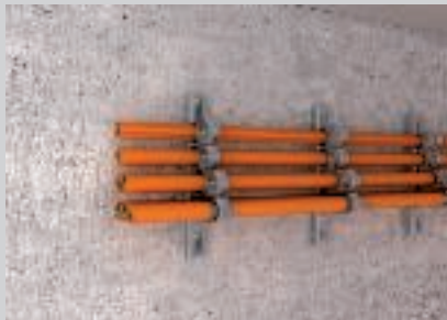
Vodoravna montaža kabela s BBS obujmicama na zidu.
