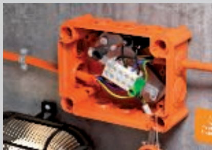
Provod kabela s utičnim brtvama.
