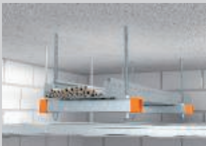
Stropna montaža iznad spušenog protupožarnog stropa u jednoj razini.
