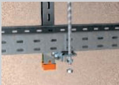
Montaža dodatne uporne točke pomoću navojne šipke i priključnog elementa na vrhu konzole.
