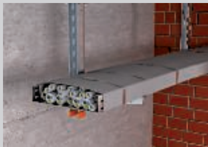
Kompletno ovijanje spuštene kabelaške trase.
