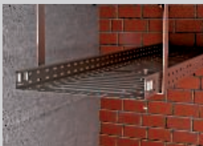
Pričvršćenje kabelske police pomoću torban vijaka.
