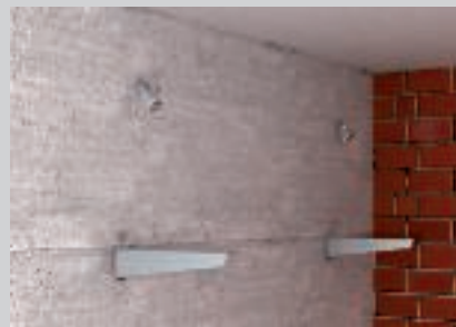
Montaža konzola i kosih priključnih elementa na zidu.
