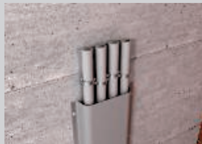
Pričvršćivanje bandaže s metalnim profilima kod instalacije kabela pomoću pojedinačnih obujmica.
