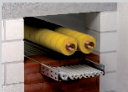
Provedene gorive cijevi s uzdužnom izolacijom.
