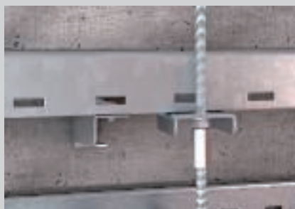
Pričvršćivanje navojne šipke za kabelske ljestve kod više razina.
