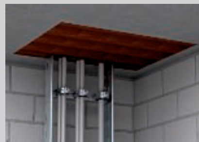
Uspravna ugradnja blokova u stropu.
