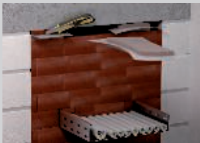
Vakuimirani blokovi za jednostavno zatvaranje preostalih otvora.
