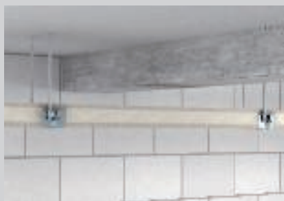
Ovjesna montaža na elementima za povezivanje.
