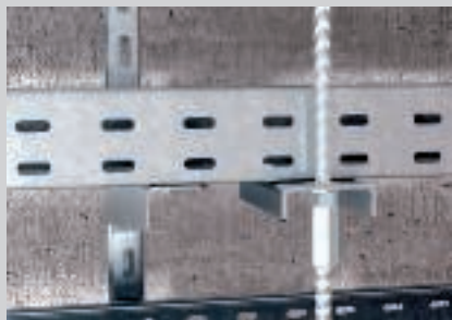
Pričvršćivanje navojne šipke za kabelsku policu kod više razina.
