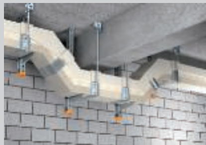
Prethodno oblikovani oblici za promjene smjera kod obješene montaže.
