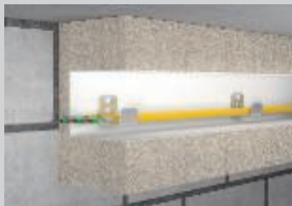
Pridržni kutnici kao pomoć pri montaži za umetanje svjetlosnih kabela (LWL).
