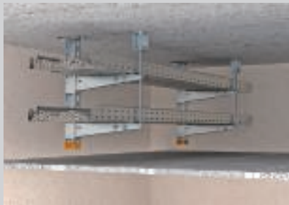
Ovjes sa stropa s jednostrano raspoređenim konzolama u dvije razine.
