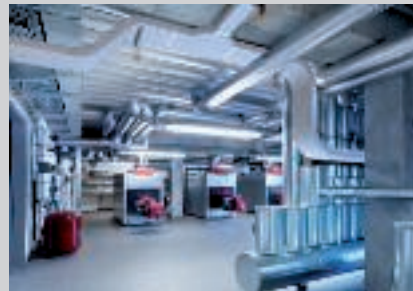
Primjena na sustavima nosača kabela u prostorijama za održavanje ili proizvodnim pogonima.
