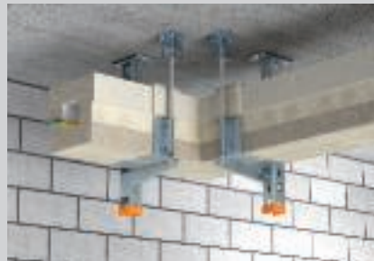
Spuštena stropna montaža s dodatnim osiguranjem navojne šipke.
