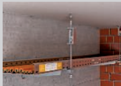
Pričvršćenje navojnih šipki na strop pomoću stropnog stremena.
