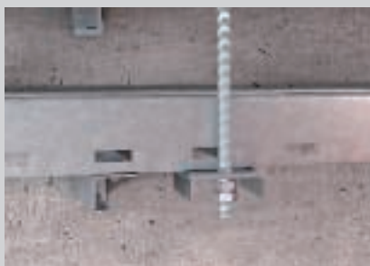
Pričvršćivanje okomite navojne šipke na priključnom elementu.
