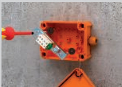
Montaža pomoću vijaka za beton kroz nosač stezaljke i dno FireBox razvodne kutije.
