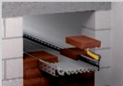
Montaža izrezanih blokova.
